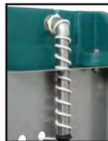
Version chauffante, arrivée d'eau à l'air libre avec un câble chauffant
