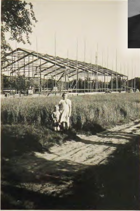
Frank Haiges avec sa cousine Inge devant le nouveau bâtiment de la fonderie à Kircheim am Neckar
